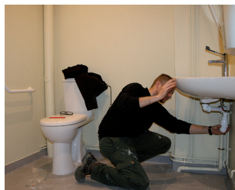
Installation de WC pour personnes à mobilité réduite à la salle M. Baquet
