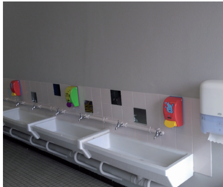
Réfection des sanitaires de l'école Eugénie Cotton par les Services Techniques
