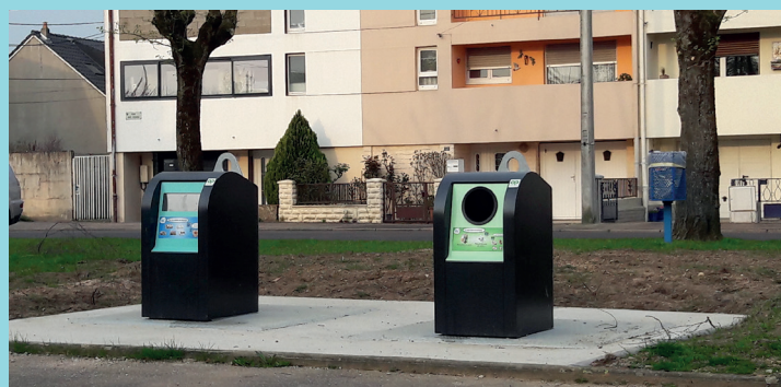
Conteneurs - rue des Roses
