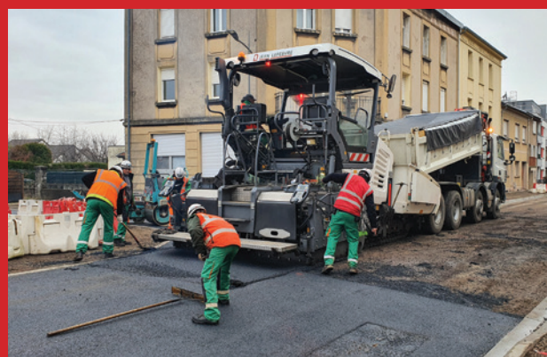
Fin de la seconde tranche de rue de l'Usine
