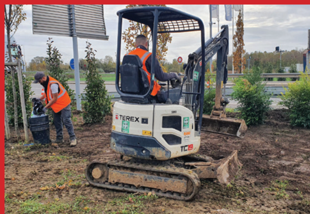
Travaux - Entrée de ville
