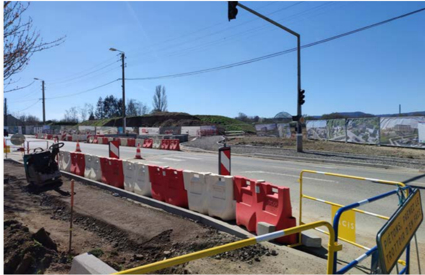
▲ Les feux tricolores cèdent leur place à un giratoire pour fluidifier la circulation rue de Metz.
