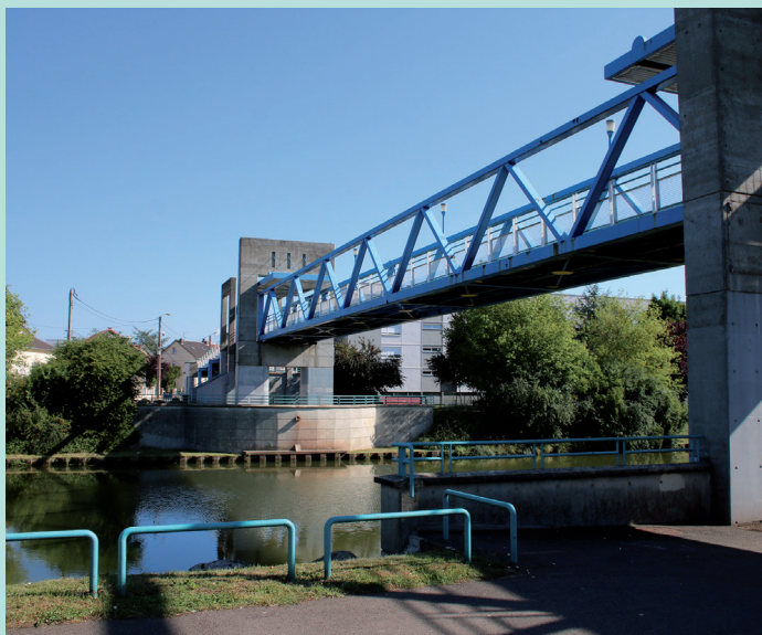
Passerelle Charles Anstett avant sa rénovation
