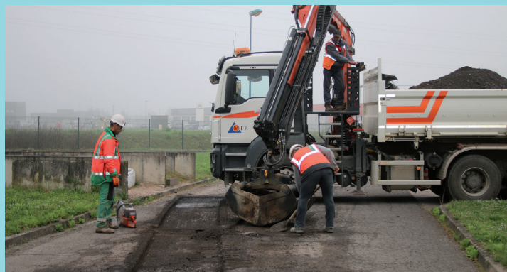
Réfection parking du Lycée Eiffel
