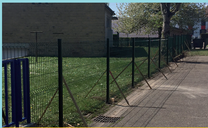
Mise en sécurité de la maison Molière et cour Ecole Jean Burger 2
