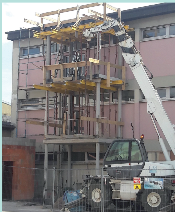
Installation d'un élévateur à la Maison des Associations
