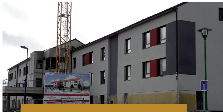
Travaux de l'EHPAD
