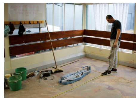
Réfection du carrelage au club house du Pétanque Club
