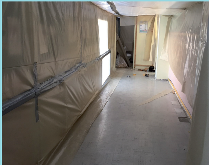
Désamiantage - Maison des Associations
