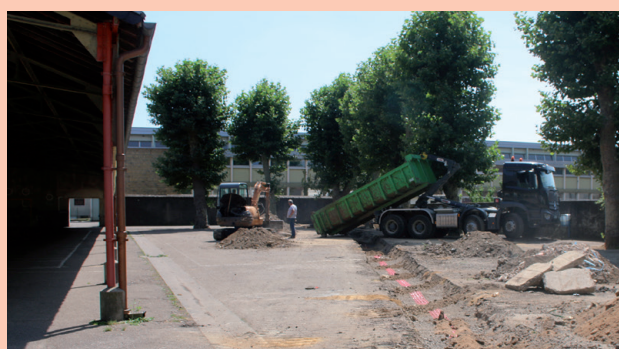
Remplacement des tuyaux de chauffage à l'école Jean Burger
